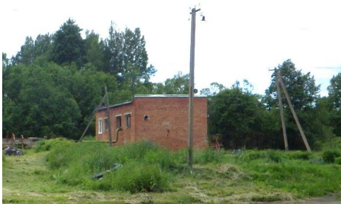
Рисунок 1. Здание КОС п. Волошово. ООО «Янэнерго»
